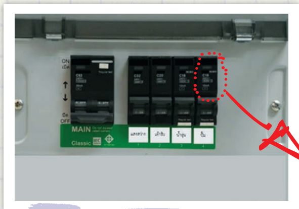
รูป ก. ตัวอย่างแผงจ่ายไฟที่ติดตั้ง เครื่องตัดไฟรั่ว (แบบ RCBO) เฉพาะวงวงจร
