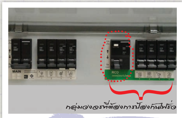
รูป ข. ตัวอย่างแผงจ่ายไฟที่ติดตั้ง เครื่องตัดไฟรั่ว ป้องกันเป็นกลุ่มวงวงจร
