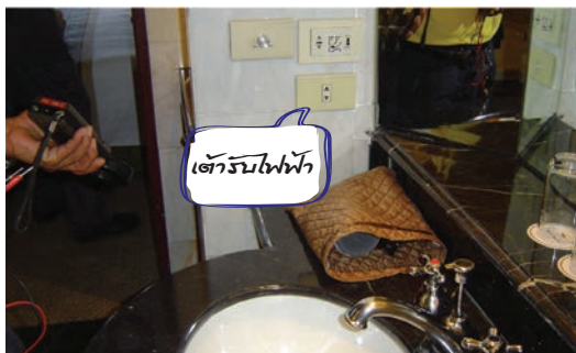
รูปที่ 7 ก) วงจรเต้ารับ บริเวณพื้นที่ เคาน์เตอร์ ที่มีการติดตั้ง เต้ารับ ภายในระยะ 1.5 เมตร ห่างจากขอบ ด้านนอกของอ่าง
